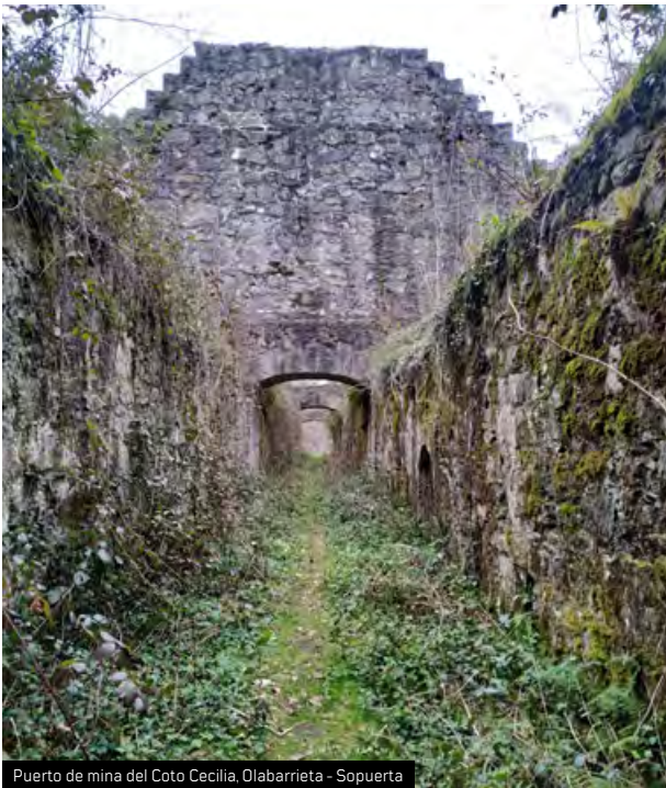
Puerto de mina del Coto Cecilia, Olabarrieta - Sopena
